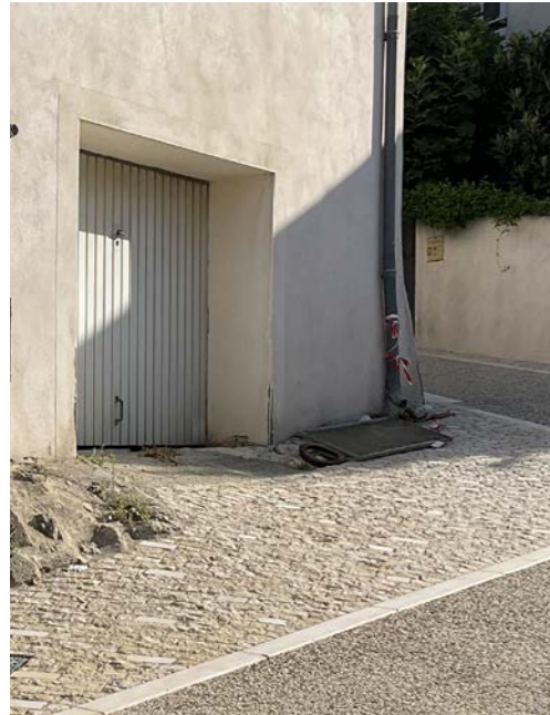
Type 1: accès garage Conservation seuils à niveau
